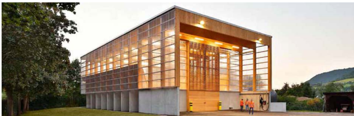
Salzlagerrhalle Geislingen Architektur: vautz mang architekten Bauherr: Staatliches Hochbauamt Ulm Foto: Martin Duckek, Ulm
